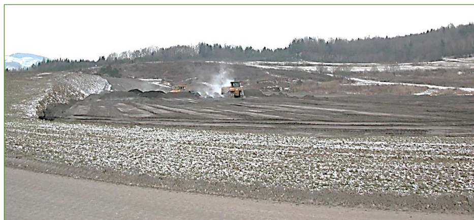
Slika 34: Obsežna površinska sanacijska dela. Foto avtor.
