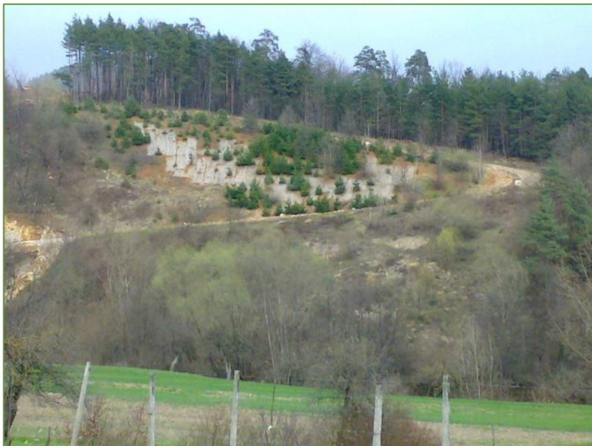
Slika 32: Tehnično saniran in samozaraščanju prepuščen stari kamnolom v Pirešici (med cesto in bori). Foto avtor.
