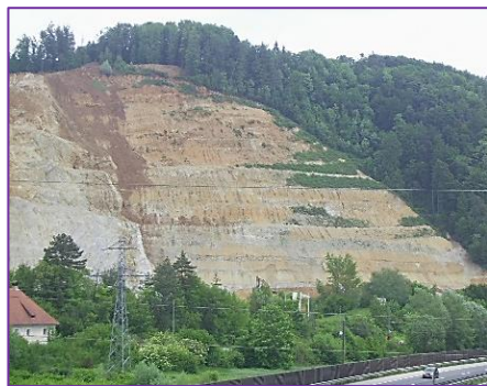
Slika 43: Sanacija v teku – kamnolom Lukovica. Foto avtor.
