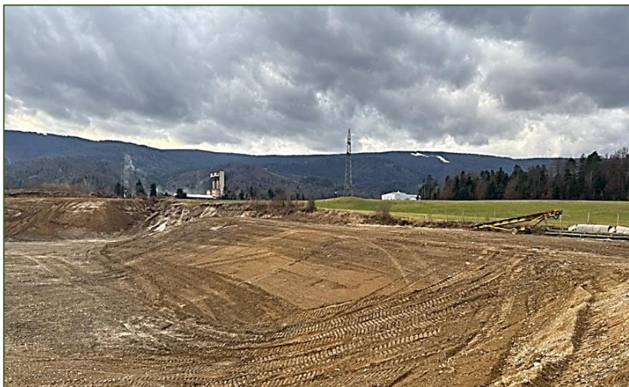
Slika 12: Izvedena tehnična sanacija brežine gramoznice. Sledi biološka sanacija. Foto avtor.
