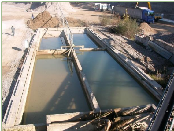
Slika 14: Usedalnik v gramoznici Pleterje za zbiranje mulja pri spiranju proda. Foto avtor.
