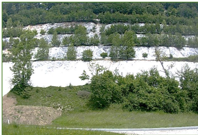
Slika 31: Nepravilno saniran kamnolom.
