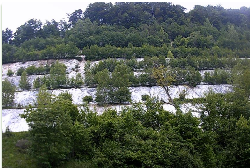
Slika 11: Nepravilno izvedena biološka sanacija – brežine niso zaraščene – erozija je velika. Foto avtor.
