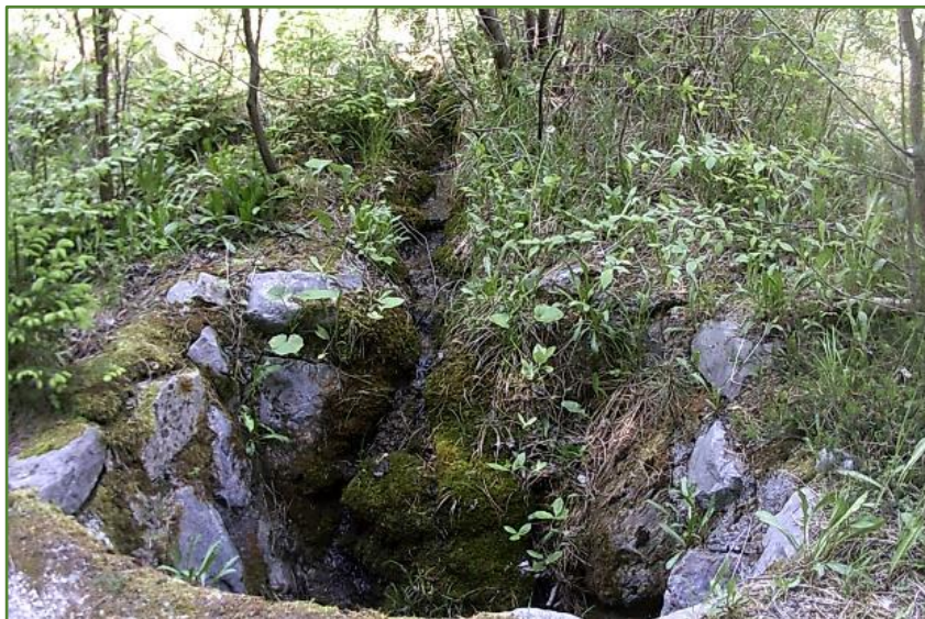
Slika 25: Odvodnjevalni jarek in zbiralnik na dnu rekultiviranega kamnoloma. Foto avtor.
